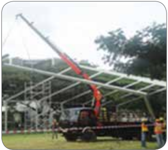
图 8: 使用随车起重机抬举帐篷架构。
