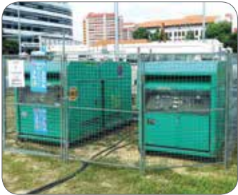
图 12: 护栏里的流动发电机
